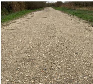
Reprise chemin du marais les phases 2 et 3 (galbe, nettoyage accotements) du chantier ont été réalisées.
